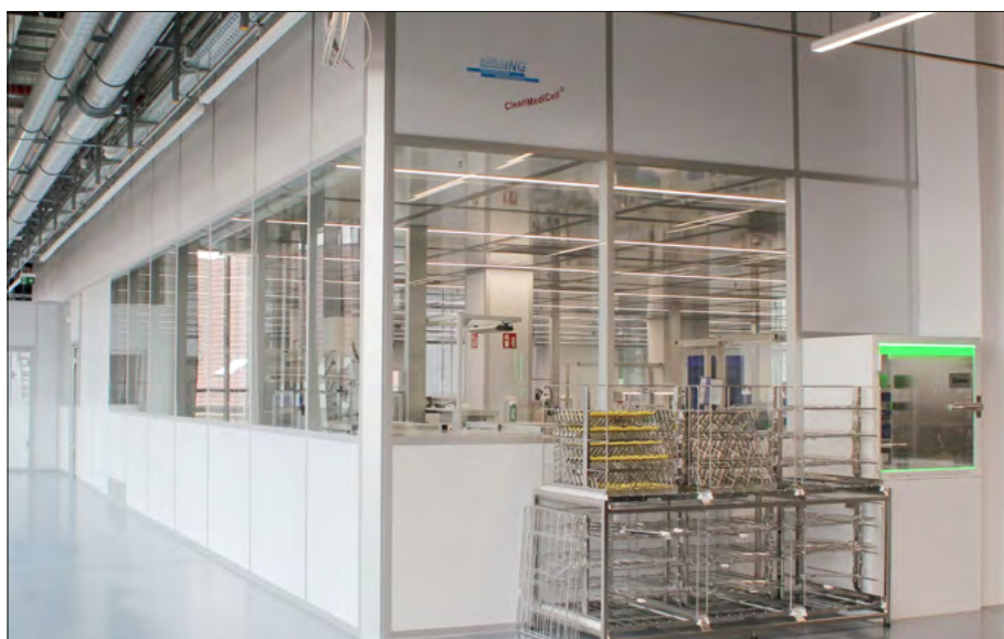
Der Reinraum Clean Medi Cell in der Aussenansicht. Rechts eine Dokumentenschleuse mit LED-Beleuchtung. (Bilder: Schilling)
